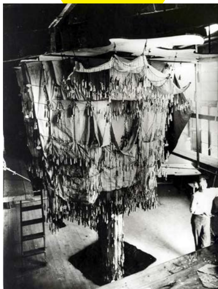
fig. ガウディによる逆さ吊り実験 *
